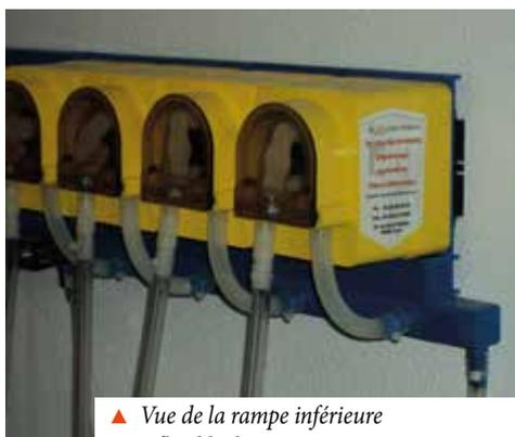
▲ Vue de la rampe inférieure avec flexible de sortie unique (alimentation laveuse en produits divers)
