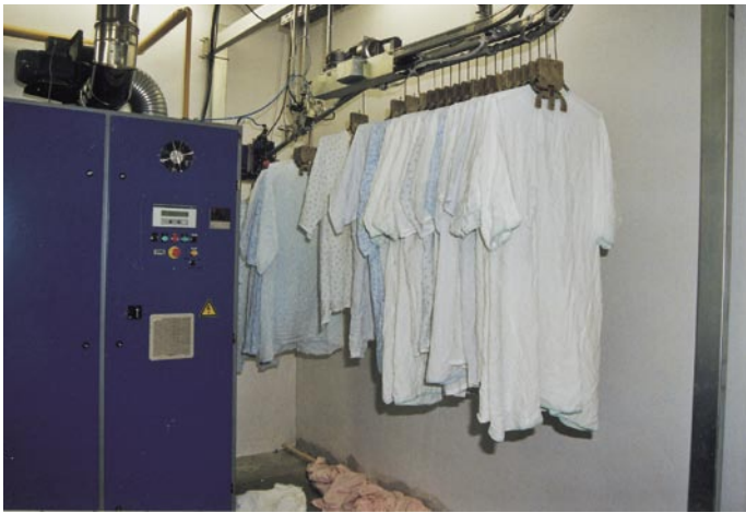
Vêtements à l'entrée d'un tunnel de finition.
